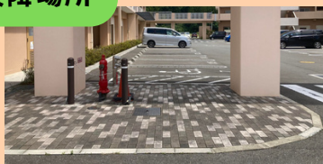
駐車場内消火栓付近 (ごみ収集所むかい)
